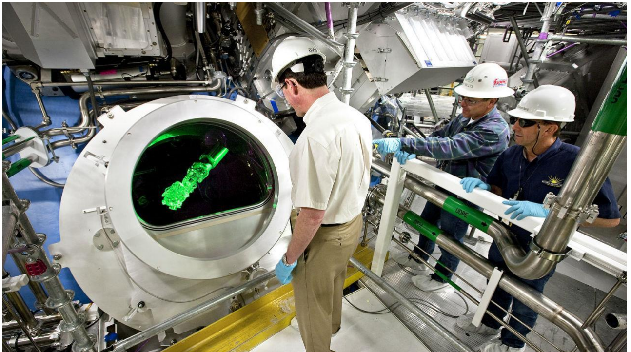
Novi prozor za gledanje nedavno montiran na odredišnoj komori National Ignition postrojenja (NIF) dopušta članovima NIF tima i posjetiteljima pogled unutar komore dok je ona vakumski zatvorena tijekom pokusa. Ožujak 2011.. Foto kredit: LLNL
