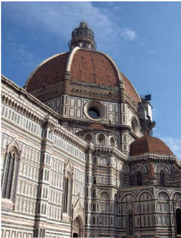
Filipo Brunelleschi (1377.-1446.) primijenio je lančanicu kao načelo fizičke geometrije u konstrukciji kupole crkve Santa Maria del Fiore u Firenci, Italija. Njegov kip stoji u vidokrugu velike kupole.
