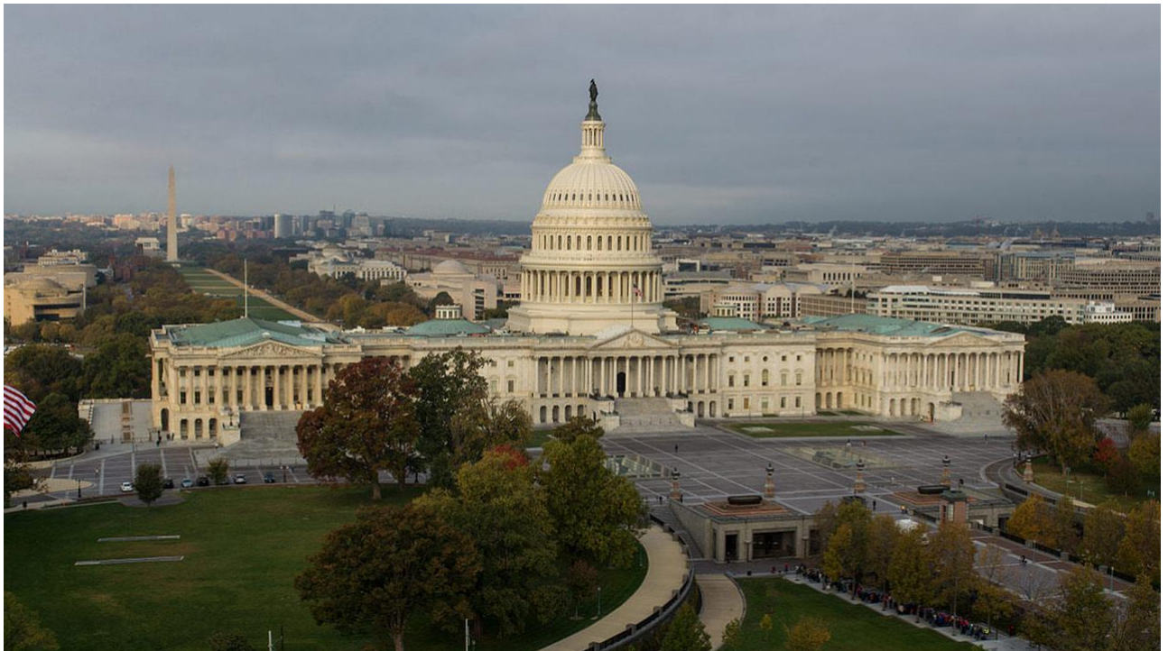
Zgrada Kapitola SADa nakon prve temeljite obnove u više od pola stoljeća. Foto: USCapitol Flickr
